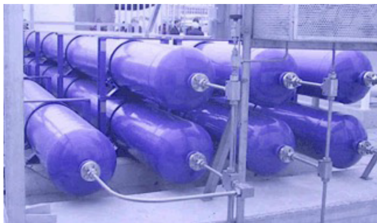
Sammler für Wasserstoff, Betriebsdruck: 450barg
